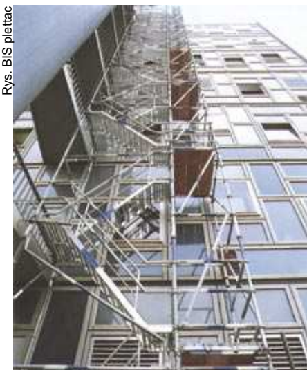
Rys. 1. Pion komunikacyjny – niezależny segment
