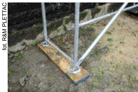
Fot. 1. Posadowienie prawidłowe
