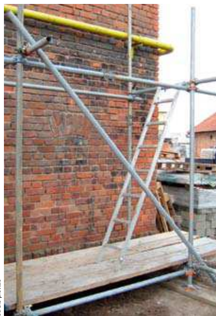
Fot. 4. Węzły rusztowania rurowo-złączkowego
