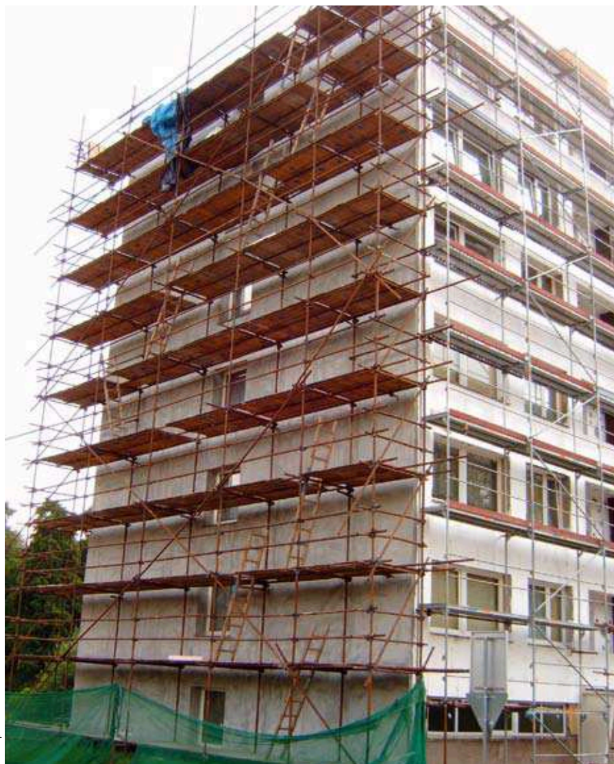
Fot. 1. Porównanie rusztowania rurowo-złączkowego z ramowym (rusztowanie w trakcie montażu)
