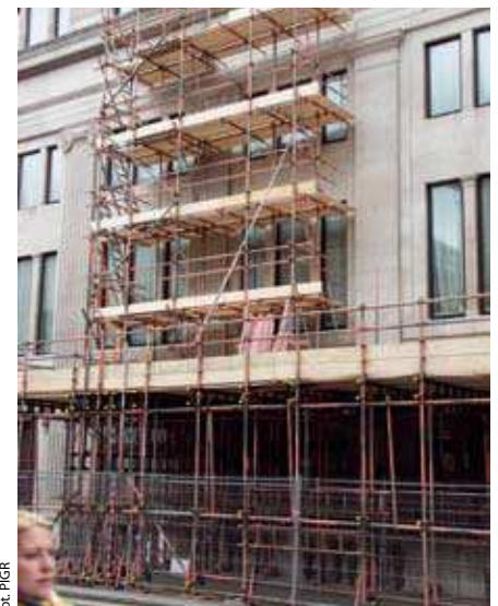
Fot. 2. Przykład rusztowania rurowego
