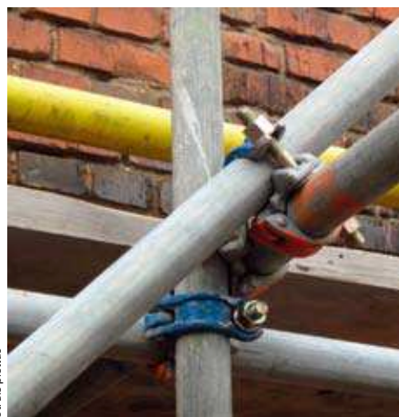
Fot. 3. Szczegół połączenia stężenia do poprzecznicy
