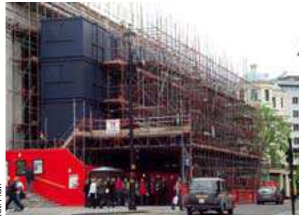
Fot. 5. Przykład rusztowania rurowego
