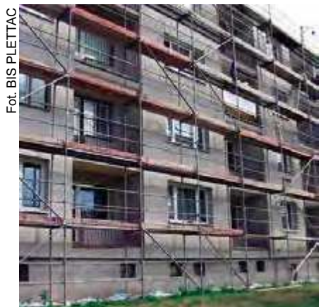
Fot. 1. Nieracjonalny układ stężeń w rusztowaniu
