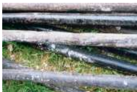
Fot. 3. Wyeksploatowane rury stalowe
