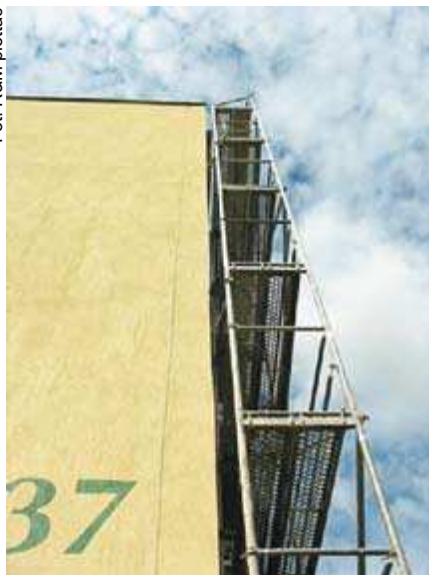
Fot. 3. Przykład rusztowań bez zabezpieczeń bocznych
