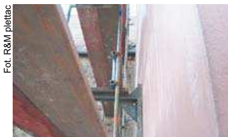
Fot. 2. Brak zabezpieczeń w przypadku, gdy rusztowanie jest oddalone od ściany więcej niż 0,2 m
