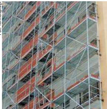
Fot. 1. Rusztowanie z prawidłowo zabezpieczoną powierzchnią roboczą
