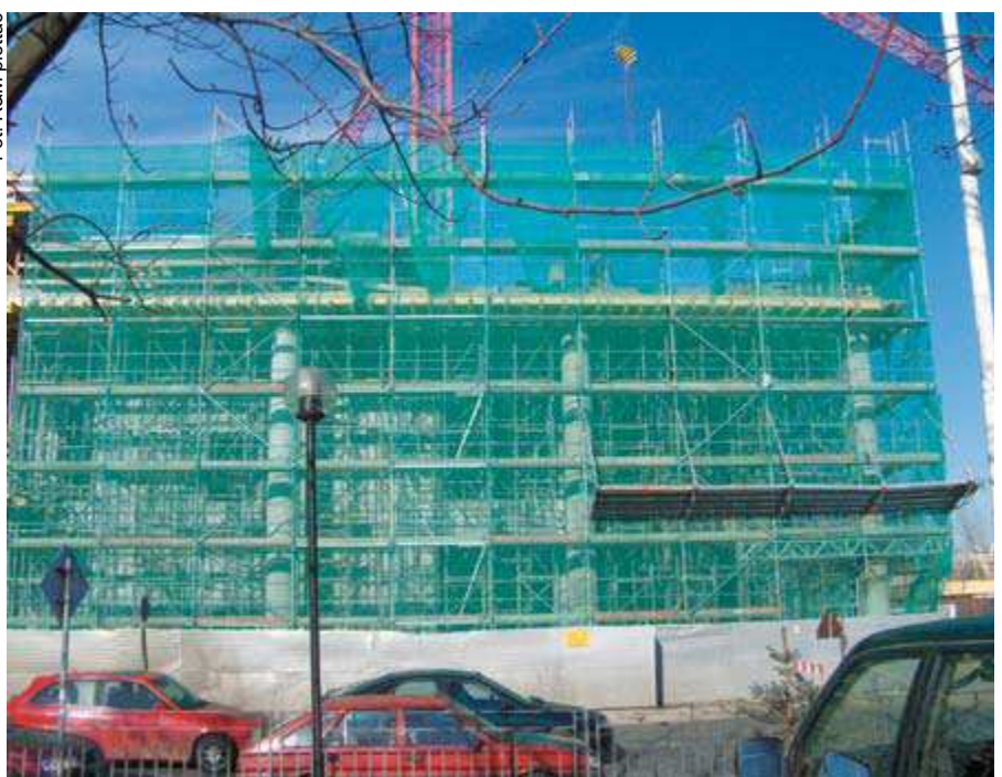
Fot. 4. Przykład rusztowania ochronnego
