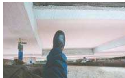
Fot. 2. Brak zabezpieczeń w przypadku, gdy rusztowanie jest oddalone od ściany więcej niż 0,2 m
